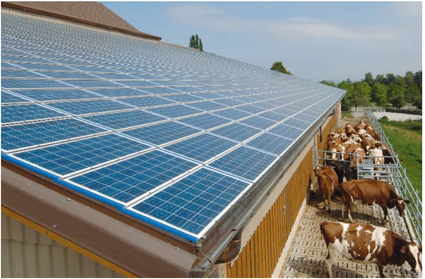
1 : Toute la surface du toit de l'étable est couverte de panneaux photovoltaïques de 110 kWp. L'intégration, les finitions du toit et tous les détails sont exemplaires. 2: Depuis le sud, vue de l'ensemble du bâtiment, avec de la place pour environ 50 unités de gros bétail.
