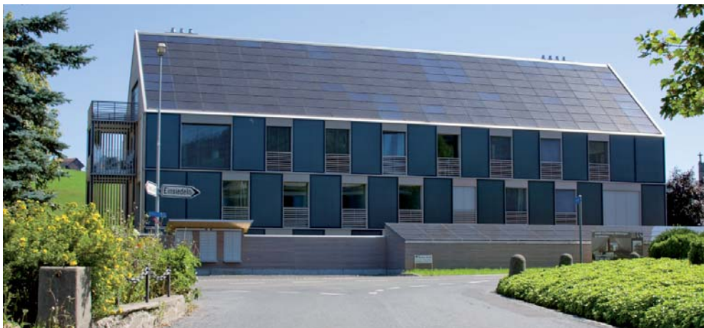
Schweizerischer und Europäischer Solarpreisträger 2009 sowie Gewinner des ersten Norman Foster Solar Awards 2010 für PlusEnergieBauten : Der mit 44 cm optimal gedämmte Minergie-P 7-Familien PlusEnergieBau in Bannau/SZ erzeugt jährlich 10% mehr Energie als er benötigt.
