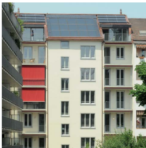
Mehrfamilienhaus-Sanierung , Basel/BS Solarpreis 2009. Mit rund 93% reduziertem Energiebedarf werden 88% der CO 2 -Emissionen gesenkt.
