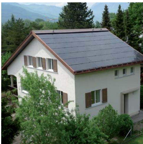
PlusEnergieBau-Sanierung , Vaduz/FL, PEB-Solarpreis 2010. Mit einem um 86% reduzierten Energiebedarf wurde eine Eigenenergieversorgung von sensationellen 182% erreicht.
