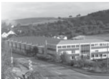
Multifonctionnalité: des sheds, du photovoltaïque, une production d'air chaud (Aerni)
