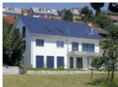
Une installation intégrée (Untersiggenthal)
