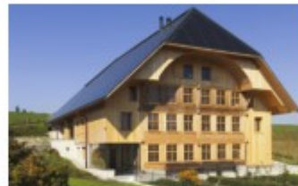
700% PEB-Sanierung, 3416 Affoltern i.E./BE
