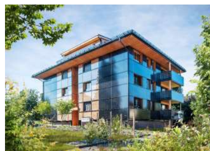
Abb. 2: Die ganzflächig integrierten solaren Dach- und Fassadenanlagen generieren mit 78'000 kWh einen Solarstromüberschuss von 53'000 kWh/a oder 315% des Gesamtenergieverbrauchs für die sieben Wohnungen (vgl. nachstehende Tabelle).
