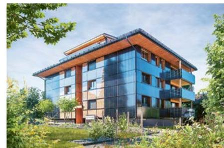
**Abb. 2:** Die ganzflächig integrierten solaren Dach- und Fassadenanlagen generieren mit 78 000 kWh einen Solarstromüberschuss von 53 000 kWh/a oder 315% des Gesamtenergieverbrauchs für die sieben Wohnungen (vgl. nachstehende Tabelle).
