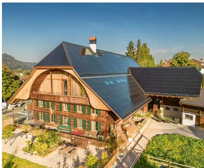
**Abb. 1:** Das denkmalgeschützte Bauernhaus von 1813 in Münsingen veranschaulicht wie historische Gebäude energetisch vorbildlich saniert werden können. Vor der Sanierung benötigt eine Wohnung 20 200 kWh pro Jahr; nach der Min. P-Sanierung noch 3400 kWh/a. Das 142% PEB-MFH erzeugt aber 78 400 kWh/a. Damit können sechs Wohnungen vollständig versorgt werden. Mit dem CO<sub>2</sub>-freien Solarstromüberschuss von 23 000 kWh/a können jährlich 15 E-Autos je 10 000 km CO<sub>2</sub>-frei fahren.
