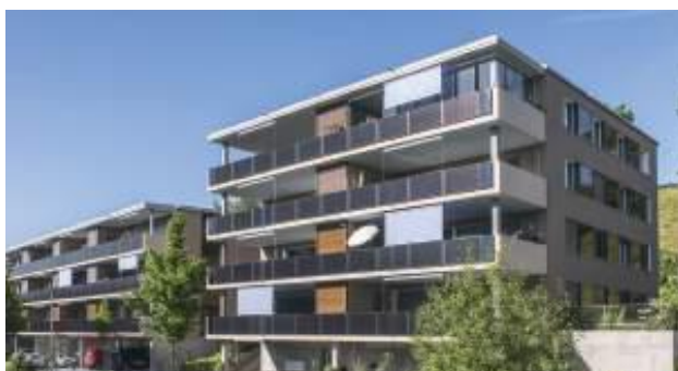
Abb. 14: Die 182%-PEB-Überbauung in Tobel-Tägerschen/ TG mit der 8.88 kW inst. Leistung pro MFH-Wohnung, veranschaulicht bereits, wie städtische PEB-MFH bei einer Schweizer Gesamtenergieversorgung mit 435 TWh Solarstrom aussehen können. Mit einer von vier Fassaden, die solar genutzt wird, können ca. 77% des Winterstrombedarfs gedeckt werden. 269 Mit einer zusätzlichen solaren PV-Nutzung der Ost-West-Fassaden könnte auch der Winterstrombedarf zu etwa 115% generiert werden. Wer zweifelt, fährt am besten nach Tobel-Tägerschen und schaut diese PEB-Überbauung selber an. (vgl. Basis-PEB Abb. 4)
