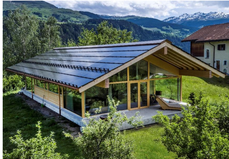
Abb. 5: Das 2019 in Waltensburg/GR erstellte PEB-Einfamilienhaus Brunner-Bapst produziert jährlich 40'200 kWh . Dank Minergie-P-Dämmung benötigt es insgesamt nur 4'900 kWh/a . Die 817%-Eigenenergieversorgung sorgt für einen Stromüberschuss von 35'200 kWh/a . Damit können 25 Elektroautos je 10'000 km pro Jahr abgasfrei fahren und insgesamt ca. 65 t CO 2 -Emissionen vermeiden. Die Energiewende und das Pariser Klimaabkommen werden mehrfach erfüllt und übertroffen (Schweizer und Norman Foster PEB Solarpreis 2020; S. 26-34).
