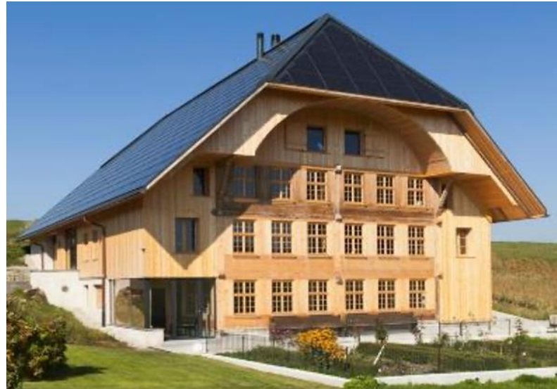
Abb. 3: Das 2015 sanierte 700% PEB-Doppelfamilienhaus Anliker von 1765 verbrauchte vor der PEB-Sanierung fast 200'000 kWh/a; dank Min.P Sanierung wurden 93.4% Energieverluste reduziert, es benötigt für zwei Familien insgesamt noch 13'000 kWh/a. Das MFH erzeugt 90'500 kWh; der PEB-Solarstromüberschuss beträgt 77'500 kWh/a CO 2 -freien Solarstrom. Damit können 55 E-Autos jährlich je ca. 10'000 km emissionsfrei fahren. Winterstrombedarf: knapp 8'000 kWh/a – Winterstromproduktion 21'000 kWh/a.
