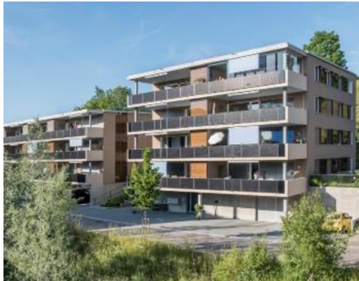
Abb. 4: Die 182% PEB Siedlung mit 32 Wohnungen in Tobel/TG deckt mit 129'500 kWh/a 100% des Gesamtenergiebedarfs. Sie generiert insgesamt 236'300 kWh/a, davon ein Stromüberschuss von gut 106'000 kWh/a. Damit können 76 E-Autos jährlich je rund 10'000 km CO 2 -frei fahren. Die Mietpreise sind 20% günstiger im Vergleich mit gleichwertigen Wohnungen in der Region. Winterstromversorgung ≈ 85% – mit PV-Ost-Westfassaden ≈ 115% Winterstromsicherheit.
