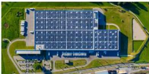
Abb. 6: Das gut integrierte Solardach des Logistikzentrums in Perlen/LU produziert mit der 6.4 MW PV-Anlage rund 7.33 GWh pro Jahr - mehr als 4 Kleinwasserkraftwerke (KWKW) . Mit dem Solarstromüberschuss von 4.2 GWh/a können 3'000 E-Autos jährlich je 10'000 km CO 2 -frei fahren, mit dem gesamten Solarstrom sogar 5'200 E-Autos . Dies entspricht der PW-Flotte einer Kleinstadt .
