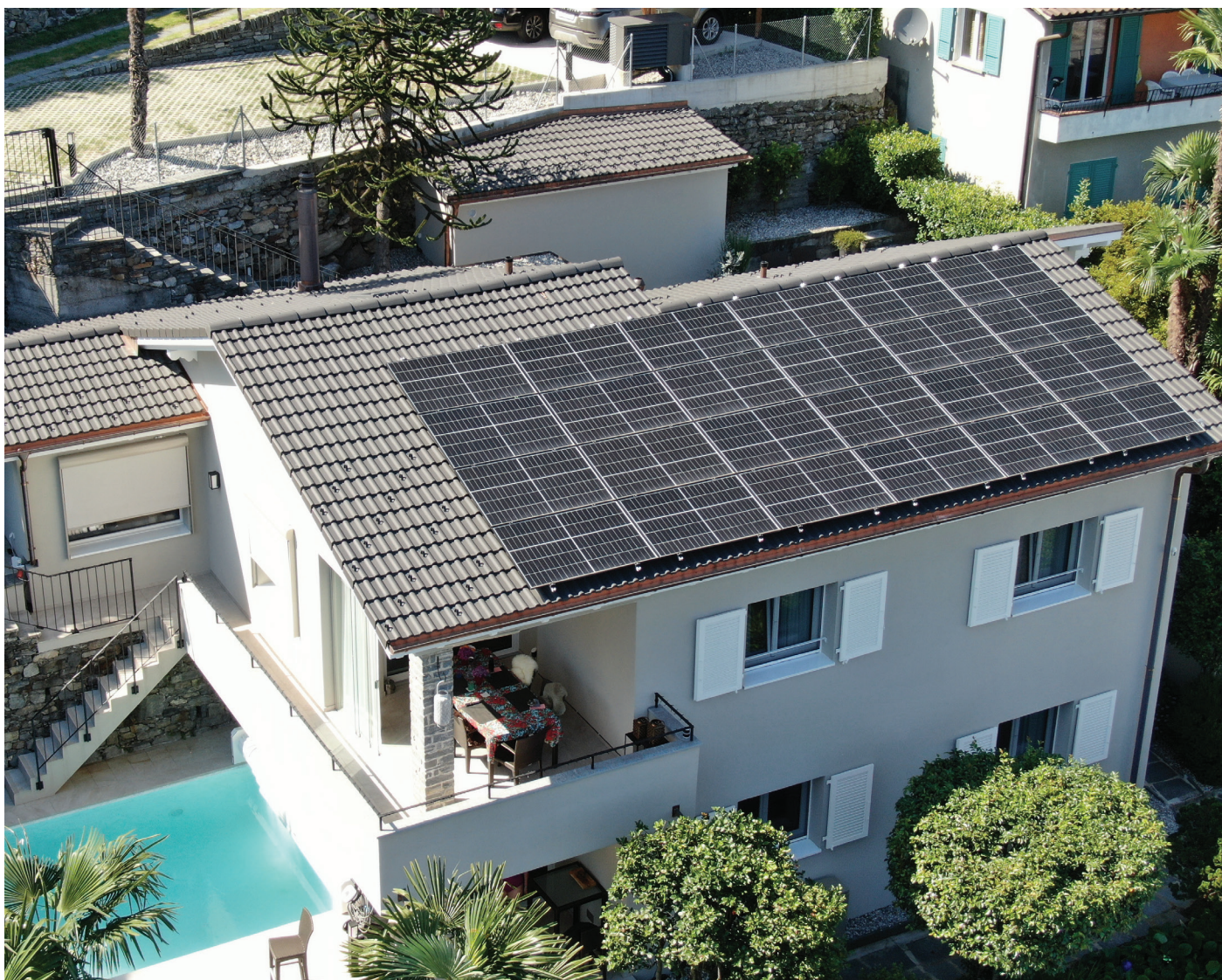
Abb. 2: Bei der Renovation wurde zur der Installation der 9.6 kWp starken Dach-PV-Anlage auch eine umfassende energetische Sanierung umgesetzt, welche den jährlichen Energiebedarf von 48'600 kWh auf 8'300 kWh oder um 83% reduziert.
