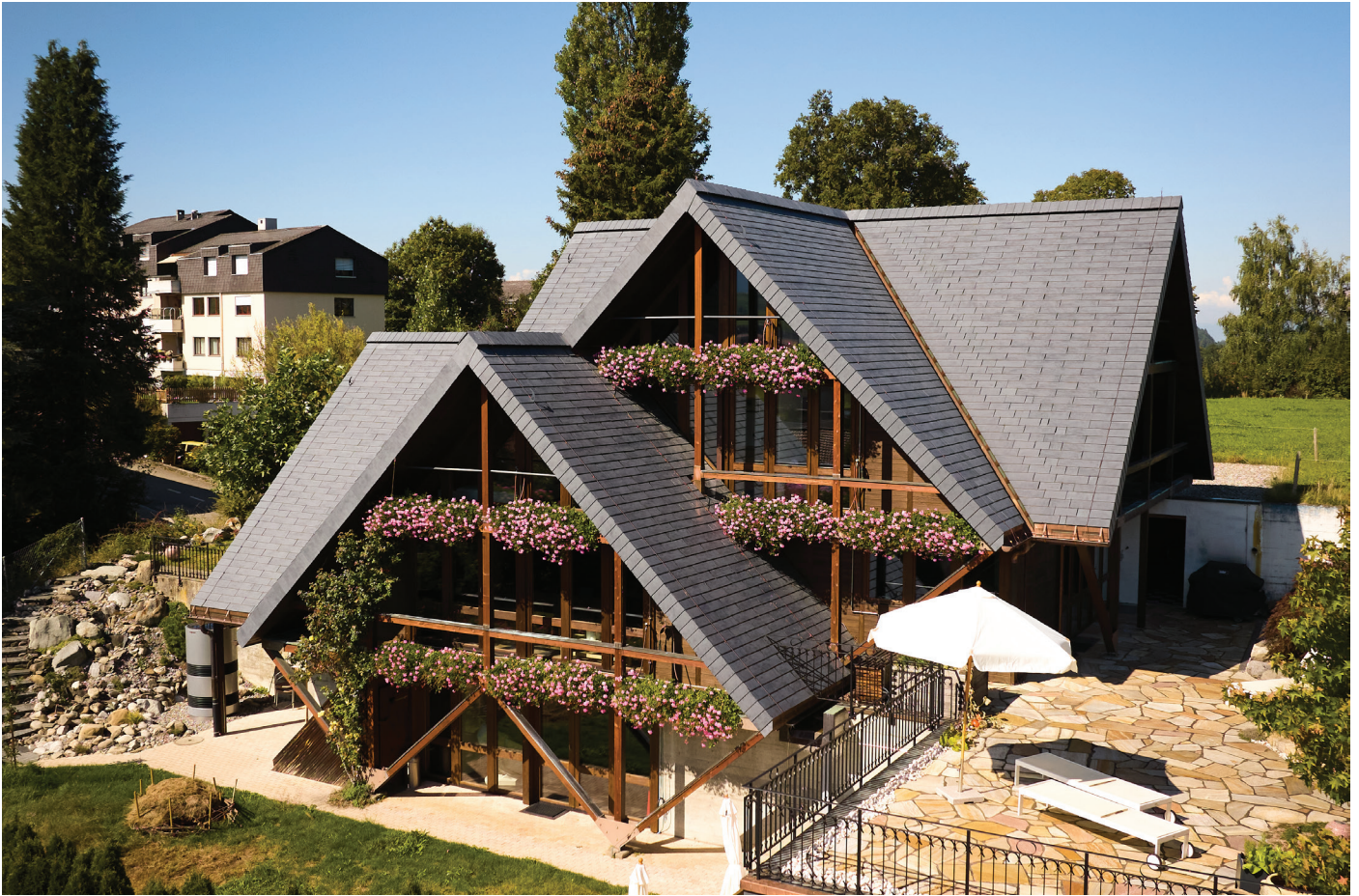
Abb. 1: Das neu installierte Solardach der Villa in Schwarzenburg erzeugt 31'000 kWh pro Jahr und verbraucht 19'500 kWh. Dies führt zu einer Eigenversorgung von 159%.
