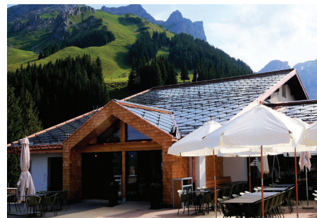
2 Die 97 kW starke Solaranlage produziert jährlich 73'500 kWh.
