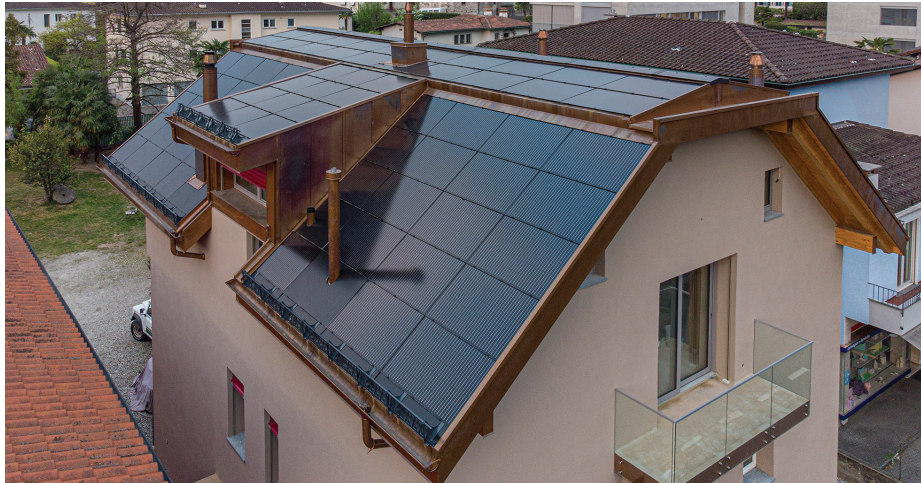
Das sanierte Einfamilienhaus der Familie Bianda in Losone mit der ganzflächig integrierten PV-Dachanlage.
