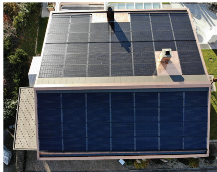
Das sanierte PEB-EFH Bärtsch in Mels (l.) wird zu 120% über die 19.8 kW PV-Dachanlage (r.) versorgt.
