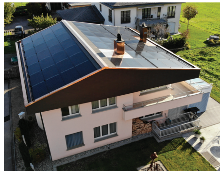
Das sanierte PEB-EFH Bärtsch in Mels (l.) wird zu 120% über die 19.8 kW PV-Dachanlage (r.) versorgt.
