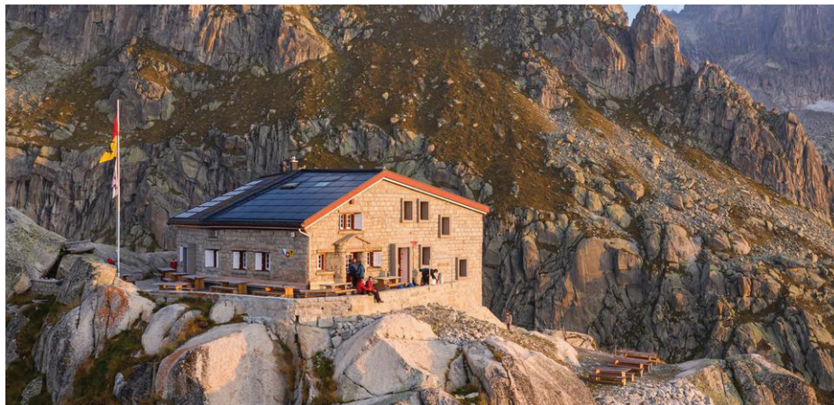
1 Albert-Heim-Hütte SAC in 6491 Realp mit einer 7.6 kW PV-Anlage und 18 m 2 thermische Kollektoren.
