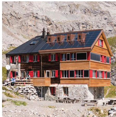
2 Lämmerenhütte SAC in 3954 Leukerbad mit einer PV-Leistung von 5.6 kW; Fassade: 1.6 kW und Dach: 4 kW.
