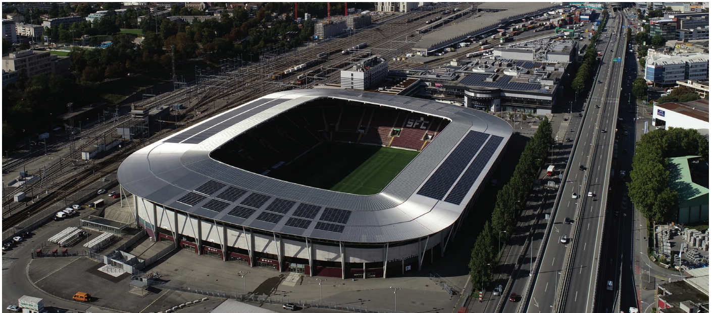
1 Stade de Genève 2021 Solarstrom PV: 942 kWc \approx 0.95 GWh/a ; émet encore 600 t CO 2 par an
