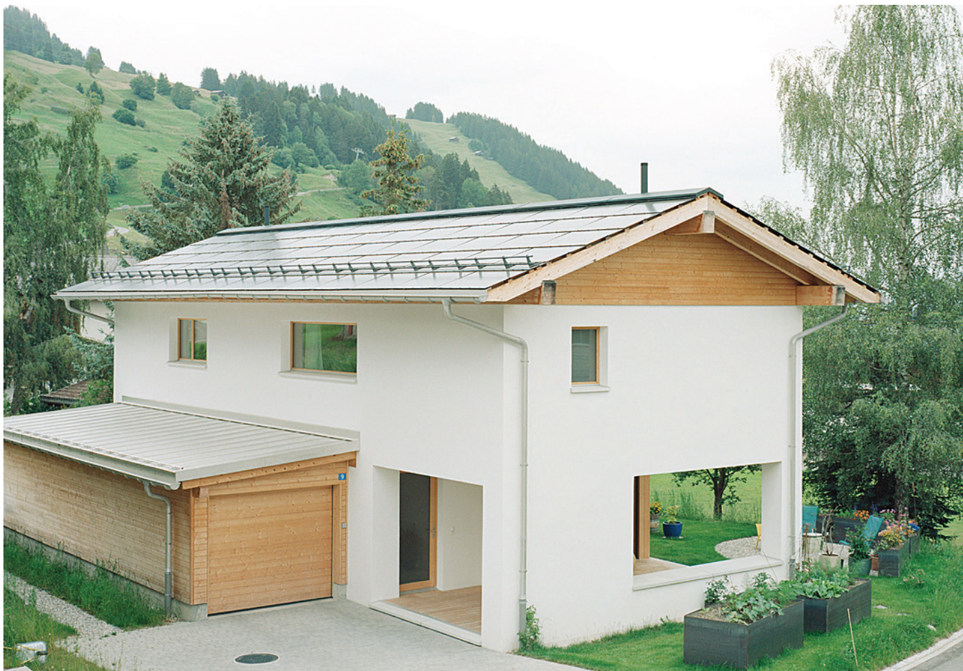
Abb. 1: Der PlusEnergie-Neubau in Breil nutzt die umweltschonende Solartechnologie: Das Dach ist mit Stroh gedämmt und ganzflächig harmonisch mit PV-Modulen ausgestattet.
