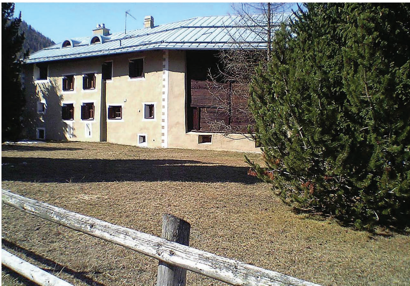
Abb. 1: Vor der Sanierung und Installation der PV-Module erstrahlte das Engadinerhaus noch in seinem ursprünglichen Zustand.
