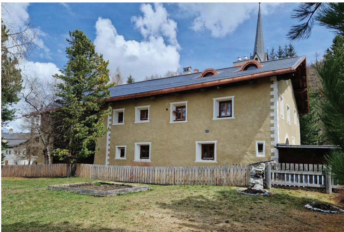
Abb. 2: Die neue Dachkonstruktion fügt sich harmonisch in das Ortsbild ein und bewahrt den ursprünglichen Charme des altherwürdigen Hauses von 1647.
