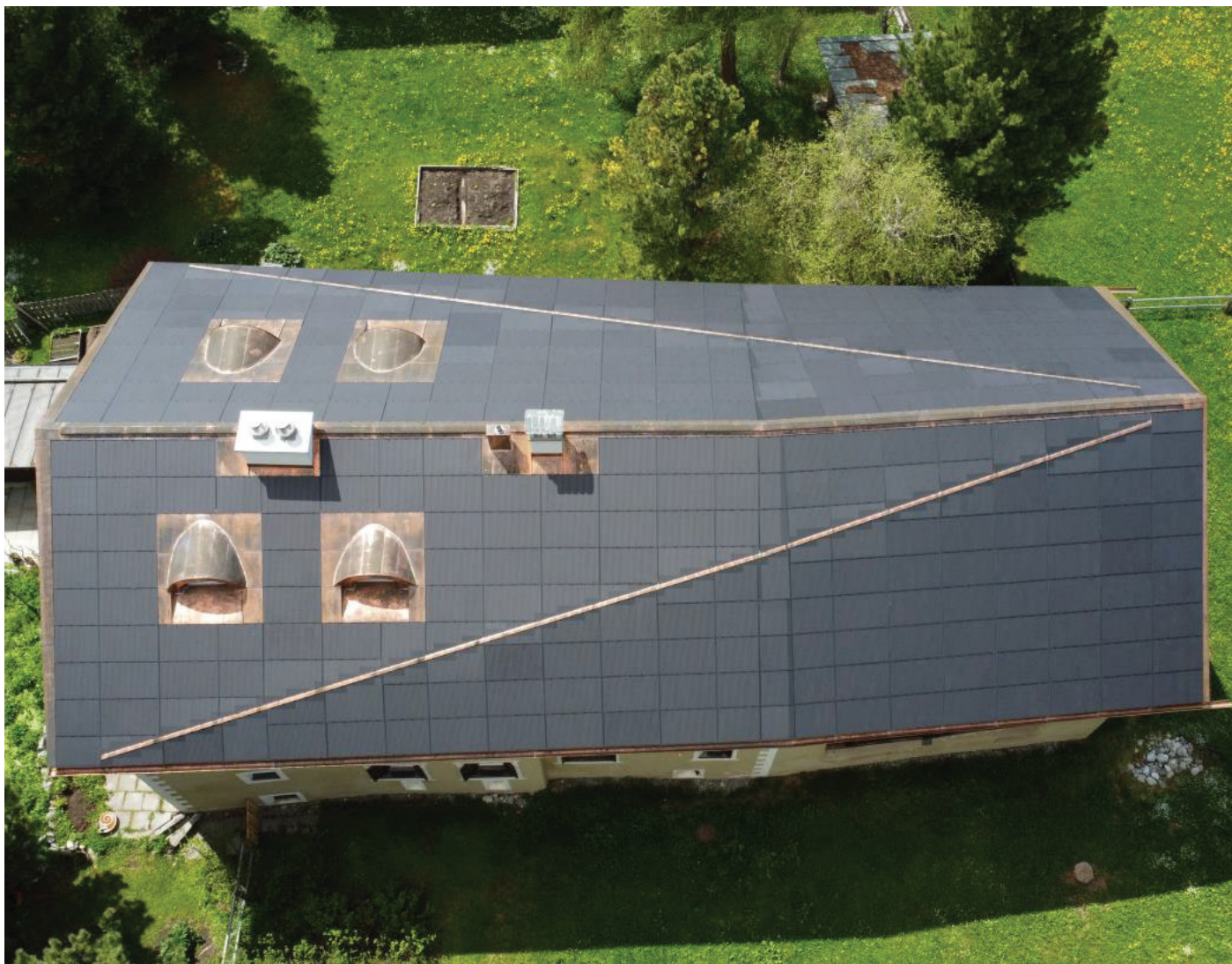
Abb. 1: Die Vogelperspektive veranschaulicht die Herausforderungen, denen sich die Bauherrschaft bei der Gestaltung der PV-Dachmodule gegenübersehen, insbesondere aufgrund der einzigartigen Dachform und Linienführung.
