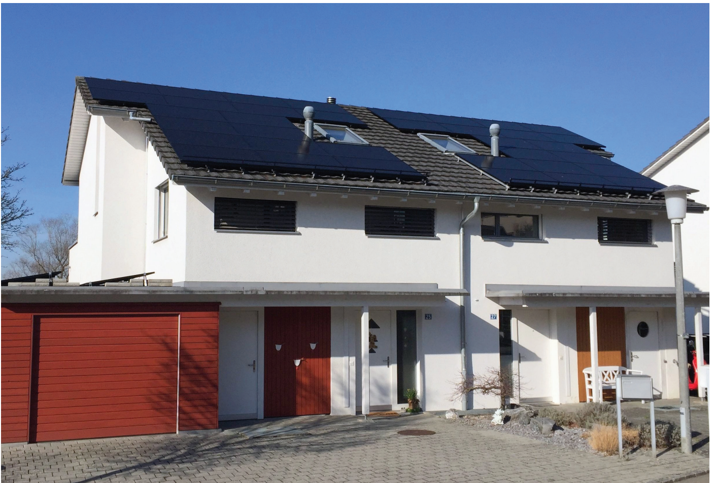
Abb. 2: Das Doppel-EFH steht in einem Quartier, welches bereits über 90% gebäudeintegrierter Solaranlagen verfügt. Die Solaragentur Schweiz gratuliert dem Quartier für seinen unermüdlichen Einsatz zur Förderung der Solarenergie.
