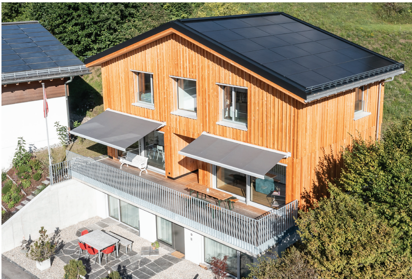
Abb. 2: Dank der integrierten Photovoltaikanlage auf dem Dach mit einer installierten Leistung von 18,72 kWp erzeugt das PlusEnergie-Gebäude 15'800 kWh pro Jahr, was zu einer Eigenenergieversorgung von 309% führt.
