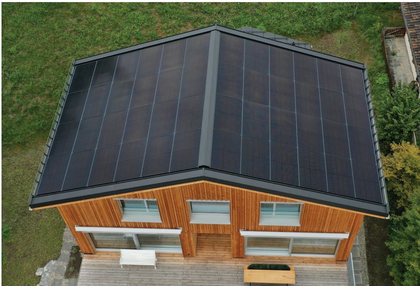
Abb. 1: In die Dachform wurden die PV-Module perfekt integriert: die Seitenabschlüsse sind bündig, die Firstbündigkeit makellos.
