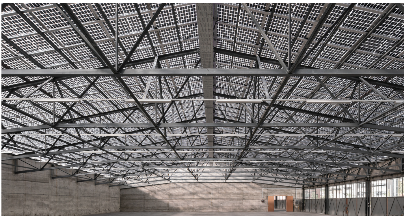
Fig. 3 : l'utilisation de modules verre-verre transparents permet de garantir qu'une quantité suffisante de lumière solaire résiduelle pénètre également dans la halle elle-même.
