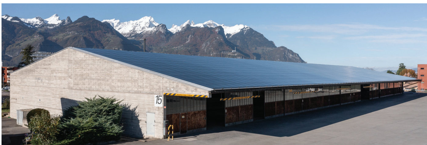
Fig. 2 : la halle armasuisse n°15 à Aigle produit jusqu'à 637'500 kWh par an grâce aux modules photovoltaïques verre-verre. Ce projet doit servir de modèle pour d'autres halles appartenant à armasuisse Immobilier.
