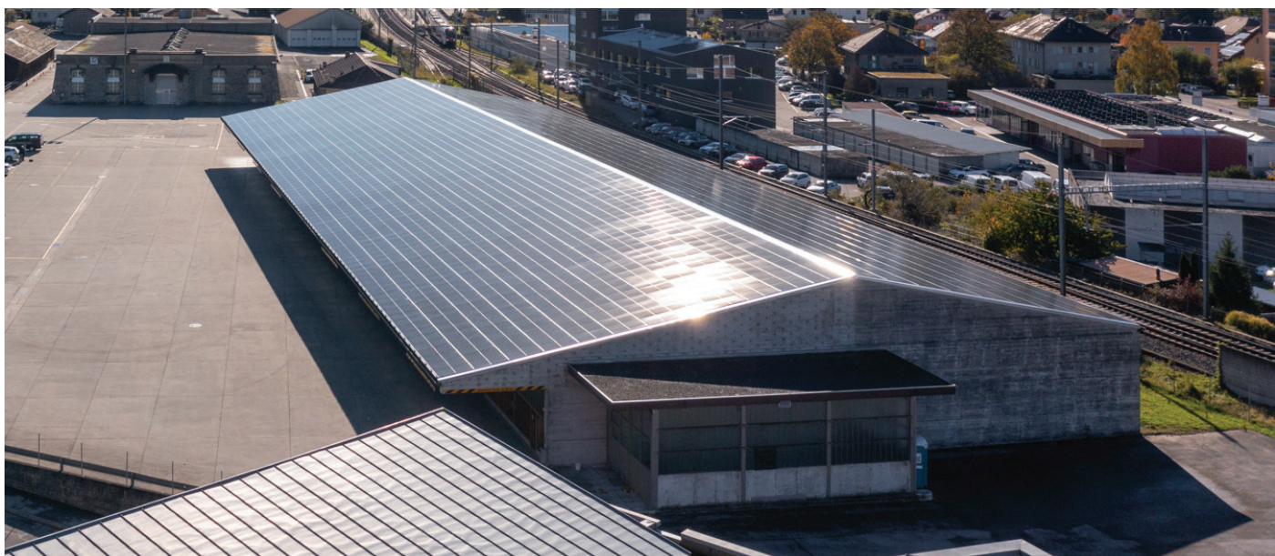
Fig. 1 : la vue à vol d'oiseau montre à quel point les modules PV ont été parfaitement intégrés dans la forme du toit.
