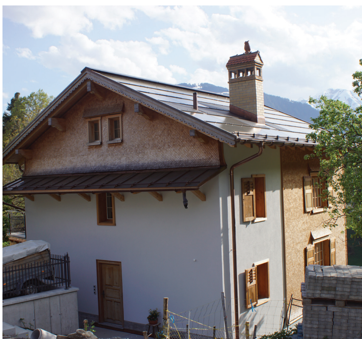
Abb. 2: Das Gebäude ist in zwei Bereiche gegliedert: Es beherbergt sowohl eine Einfamilienwohnung als auch einen Gewerbebetrieb.
