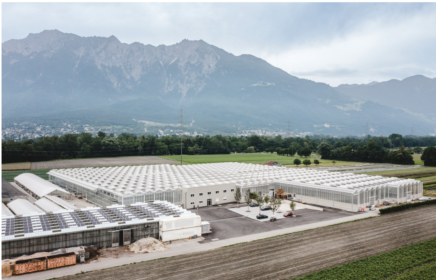
Abb. 2: Die Lubera von der Frontperspektive. Die PV-Module weisen eine installierte Leistung von insgesamt 812 kWp auf. Der Solarstromertrag ist mit 44 kWh/m 2 a höher als bei Solarziegeln oder fast so hoch wie bei gefärbten Solarzellen (Schweizer Solarpreis 2018, S. 65 und 79).
