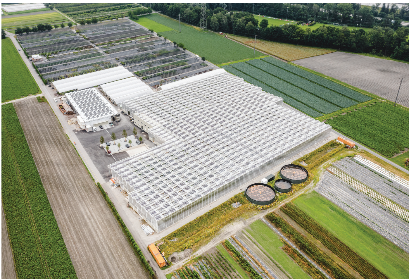
Abb. 3: Die verwendeten Glas-Glas-Module lassen ausreichend Sonnenlicht durch das Dach, sodass landwirtschaftliche Produktion nicht übermässig beeinträchtigt wird. Im Durchschnitt werden etwa 20% des Sonnenlichts für die Energieerzeugung genutzt, während 80% dem Pflanzenwachstum zugutekommen.
