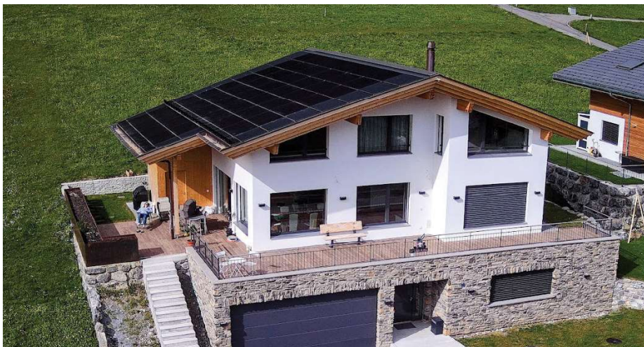
1 Das PlusEnergie EFH in Brienz generiert mit der PV-Dachanlage rund 13'700 kWh/a Solarstrom.
