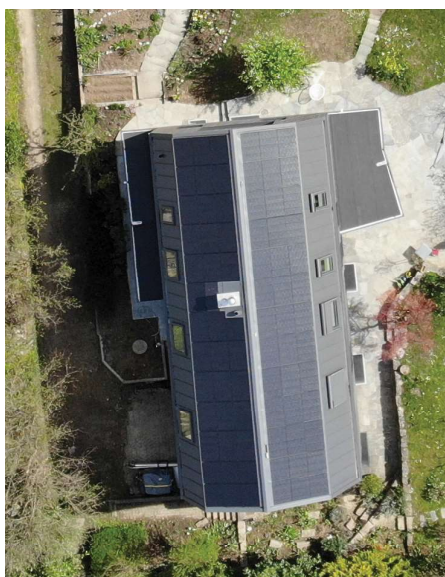
2 Die PV-Dachanlage generiert jährlich rund 14'100 kWh CO 2 -freien Solarstrom.
