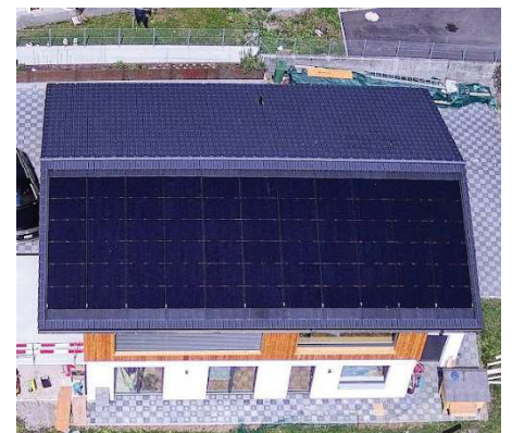
2 Die PV-Anlage generiert jährlich rund 11'700 kWh CO 2 -freien Solarstrom.
