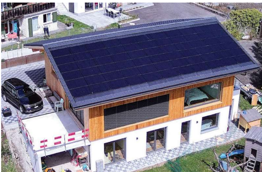
1 Das PlusEnergie-EFH verfügt über eine installierte Leistung von 12.9 kWp.
