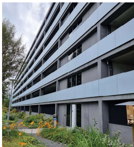
2 Die PV-Fassadenanlage generiert jährlich rund 68'200 kWh.
