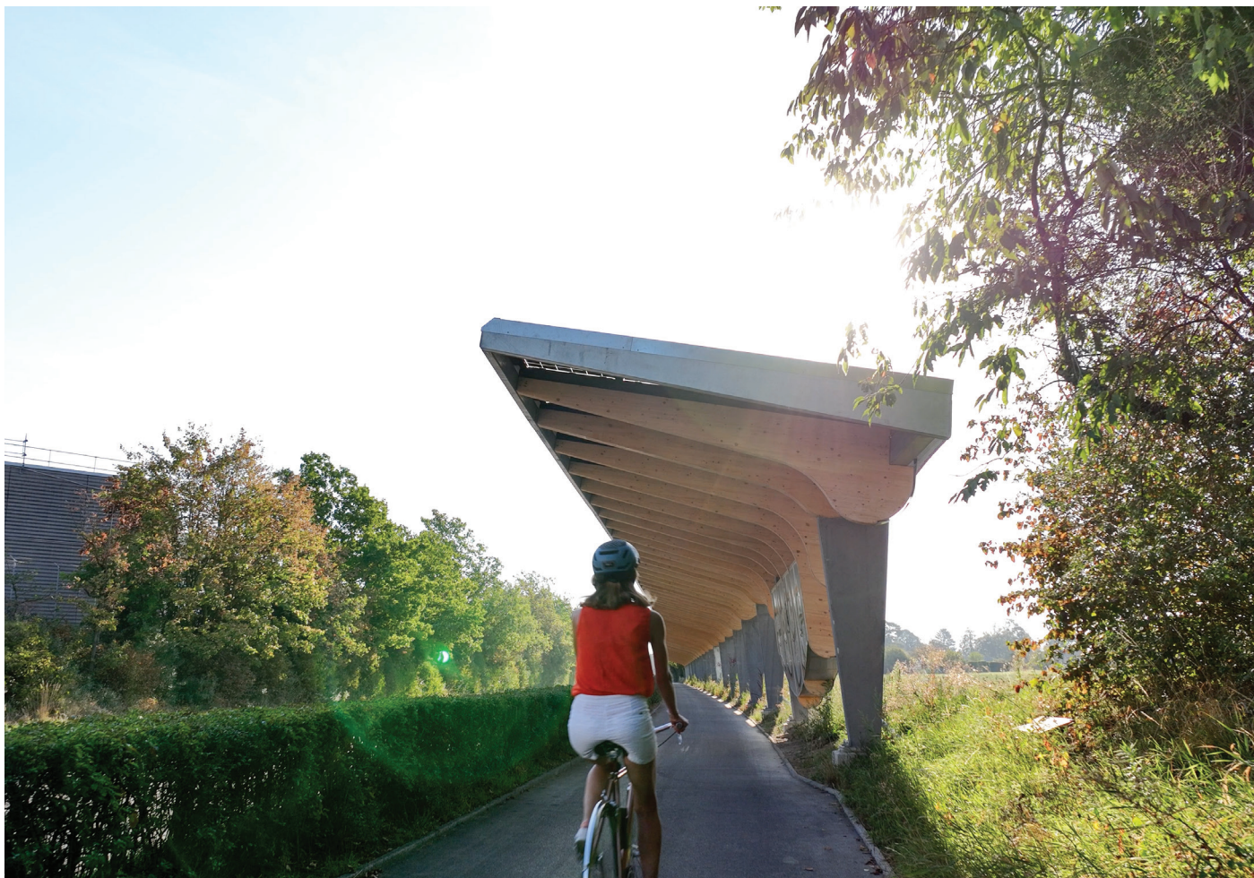
Fig. 1 : l'auvent de protection sur la piste cyclable permet non seulement de produire de l'énergie solaire, mais sert également de protection contre les intempéries pour les utilisateurs, ainsi que de protection de l'asphalte. Le projet remplit ainsi plusieurs fonctions, tout en produisant de l'énergie solaire.
