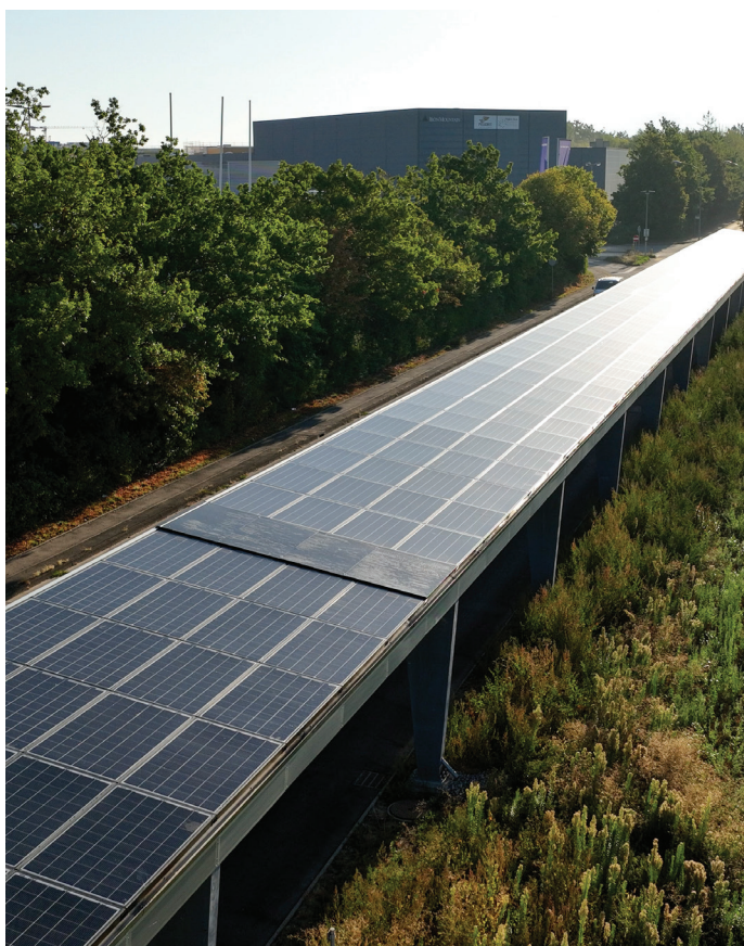
Fig. 2 : les modules PV sont parfaitement intégrés dans la forme du toit.
