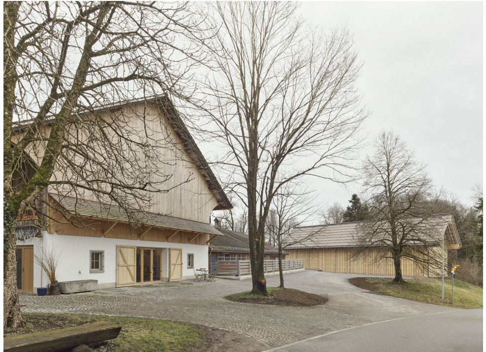
Abb. 1: Die Dachfläche der Remise im Naturschutzgebiet Lützelsee erzeugt jährlich 33'000 kWh CO 2 -freien Solarstrom. Dieser deckt den gesamten Energiebedarf des Menzihofs und speist den überschüssigen Strom ins lokale Netz ein.
