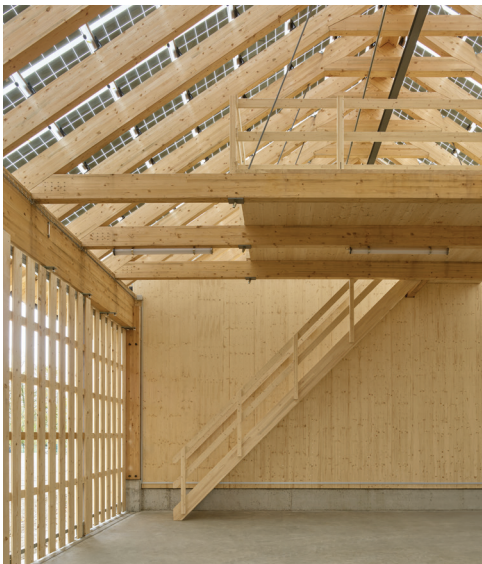
Abb. 2, 3: Durch die Verwendung lichtdurchlässiger PV-Paneele gelangt Sonnenlicht auch in die Scheune selbst, wodurch der Bedarf an künstlicher Beleuchtung erheblich reduziert wird.
