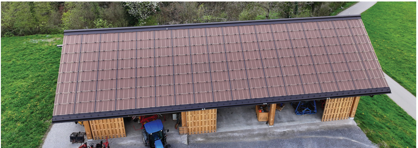
Abb. 4: Der Bau der Remise musste strenge Anforderungen in Bezug auf Natur-, Denkmal- und Landschaftsschutz erfüllen. Dank der Zusammenarbeit mit kompetenten und engagierten Partnern konnte diese Herausforderung erfolgreich gemeistert werden.
