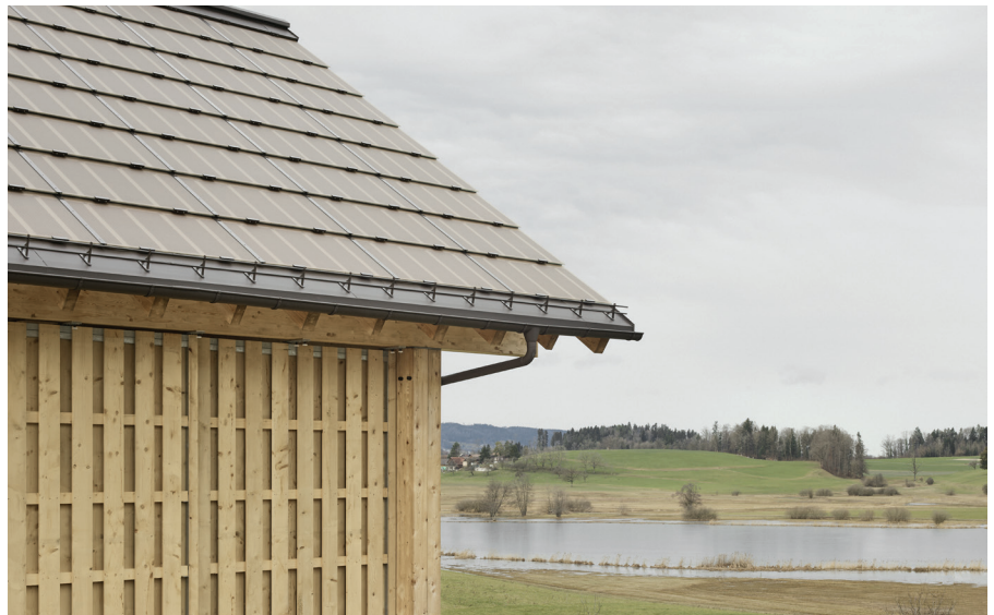
Abb. 2, 3: Durch die Verwendung lichtdurchlässiger PV-Paneele gelangt Sonnenlicht auch in die Scheune selbst, wodurch der Bedarf an künstlicher Beleuchtung erheblich reduziert wird.
