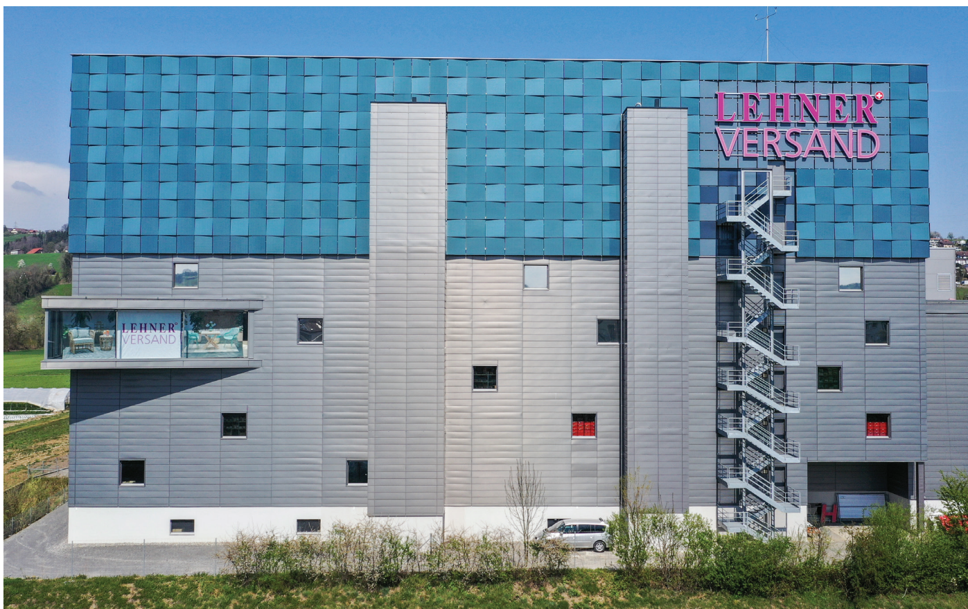
Abb. 1: Im Gegensatz zum Zustand vor der Sanierung hat die Lehner Versand AG nun auch PV-Module auf ihren Fassaden installiert, um das vorhandene Potenzial optimal zu nutzen.
