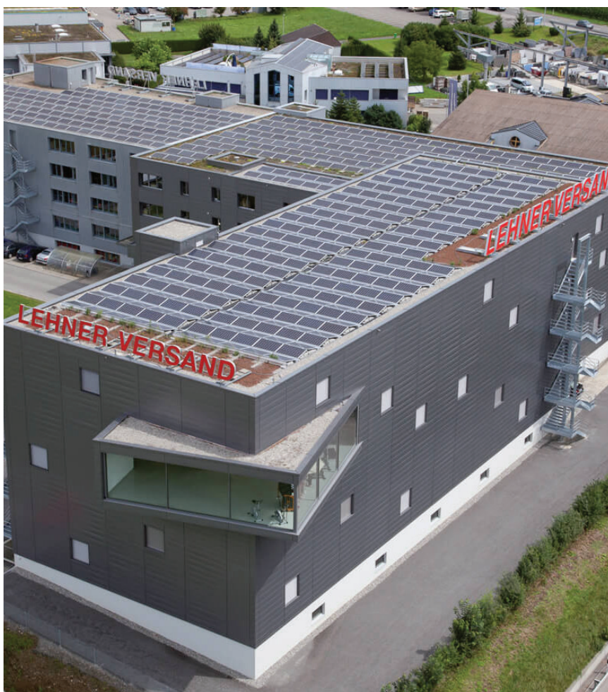
Abb. 2: Vor der Aufstockung des Gebäudes hatte dieses bereits dachmontierte PV-Module. Während der umfassenden Sanierung und Erweiterung wurden diese vorübergehend entfernt und nach Abschluss der Arbeiten wieder fachgerecht montiert.
