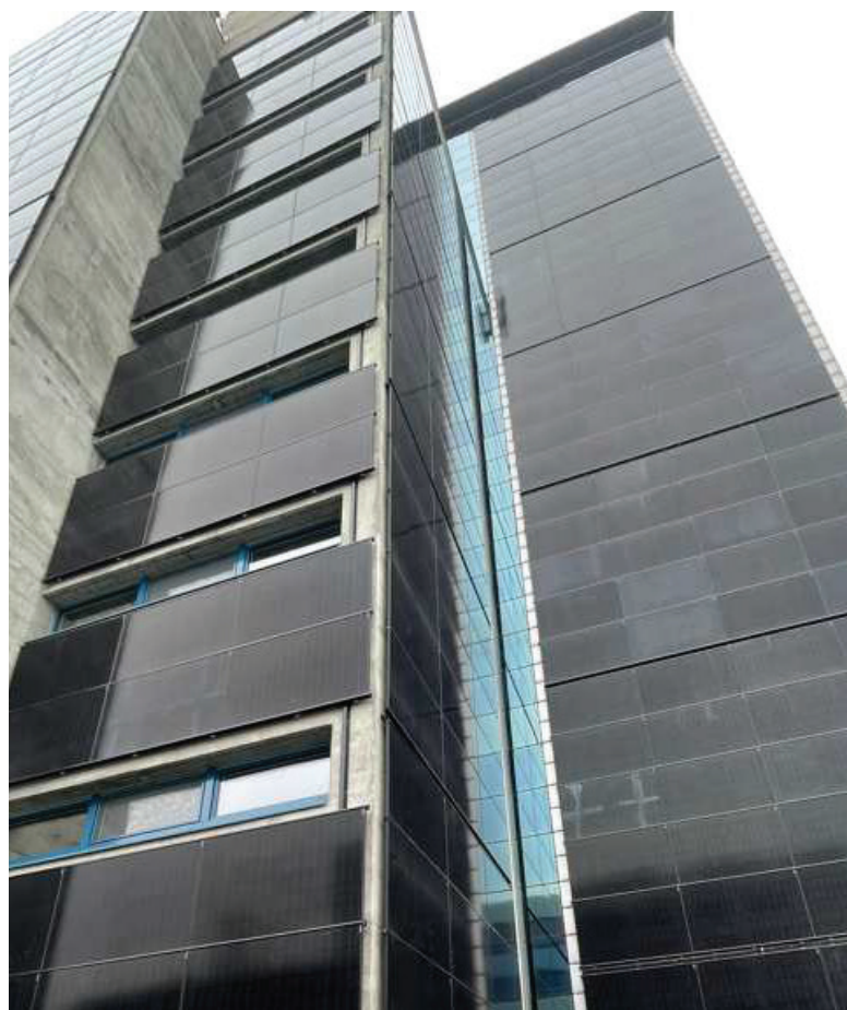
Abb. 4: Die PV-Fassadenmodule sind nur ein Teil der Solarenergie-Initiative auf dem Gelände der Schindler Aufzüge AG. Insgesamt decken die unternehmenseigenen Photovoltaikanlagen 40% des gesamten Energiebedarfs.
