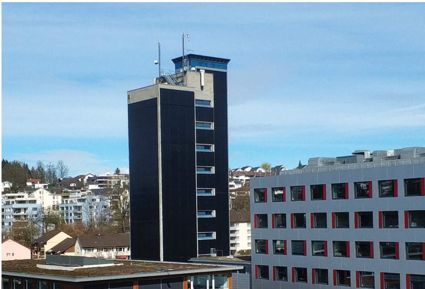
Abb. 2: Die Fassaden des Turms M+S der Schindler Aufzüge AG wurden umfassend mit PV-Modulen aufgerüstet.
