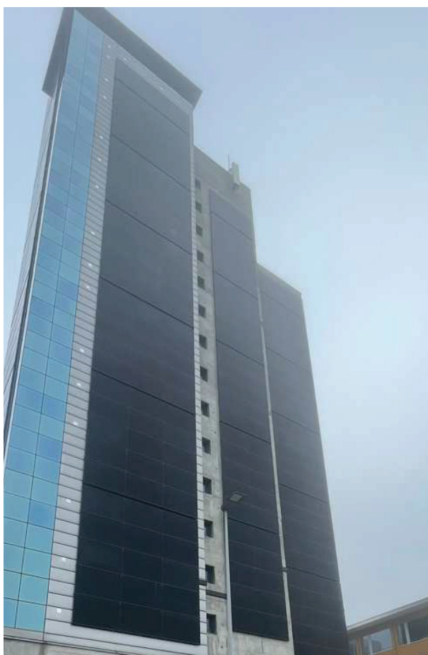
Abb. 3: Mit einer installierten Leistung von insgesamt 348.4 kWp erzeugen die PV-Module jährlich 222'100 kWh Solarstrom.
