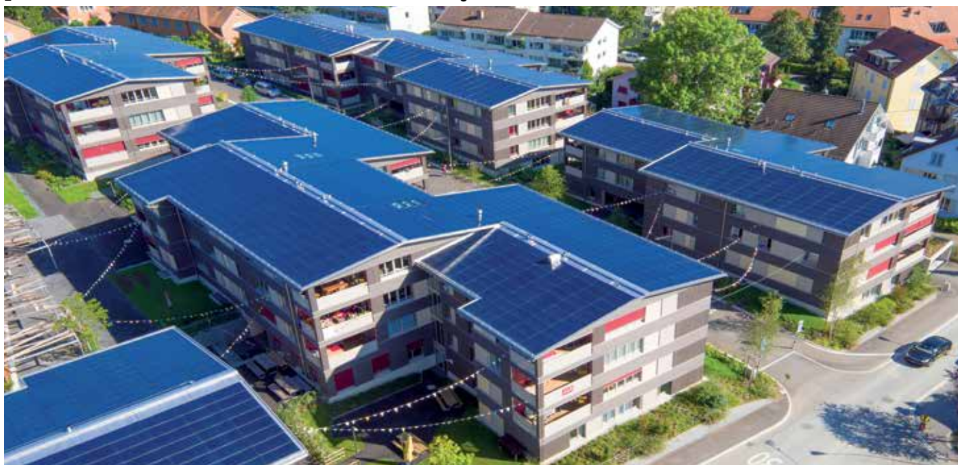
1 Gesamtansicht der ABZ-Wohnüberbauung in Zürich mit den 556 kW starken, ganzflächig optimal integrierten PV-Anlagen. Sie erzeugen jährlich 466'300 kWh. Mit dem Solarstromüberschuss könnten 49 Elektrofahrzeuge je 12'000 km/a CO 2 -frei fahren.
