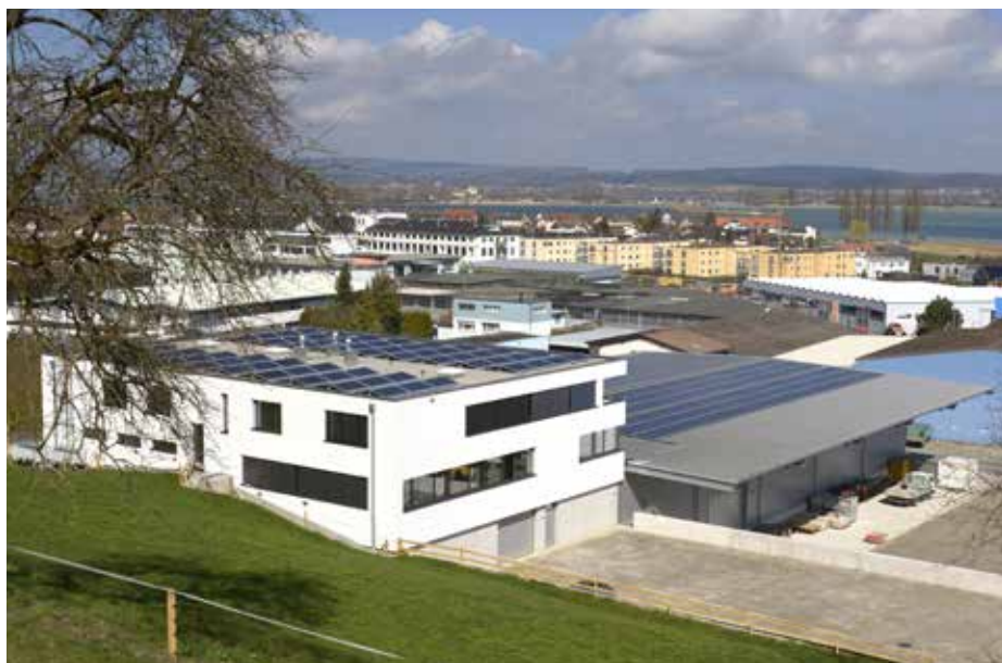
1 Südansicht des PlusEnergiebaus Kunz mit den 142-kW-PV-Anlagen, die rund 114'800 kWh/a produzieren. Damit wird eine 204%-Eigenenergieversorgung erreicht.
