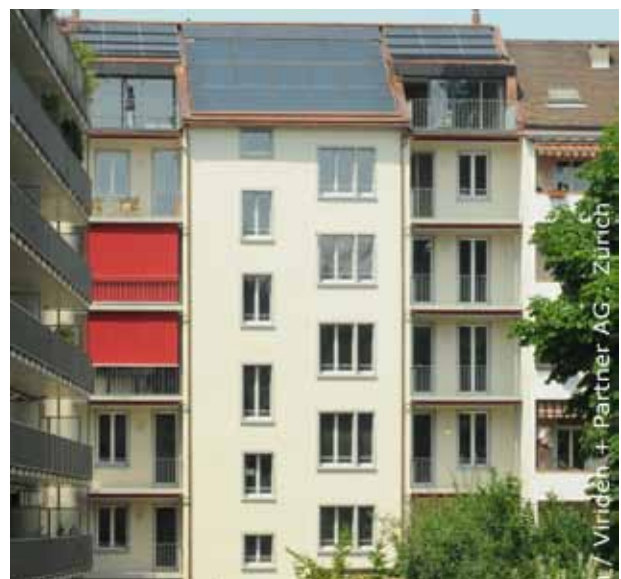
Abb. 2: MFH-Sanierung in der Schutzzone (Baujahr 1896), Basel: Die Energiezufuhr sank durch die Sanierung von 223'000 kWh/a um 91% auf heute 20'000 kWh/a!
