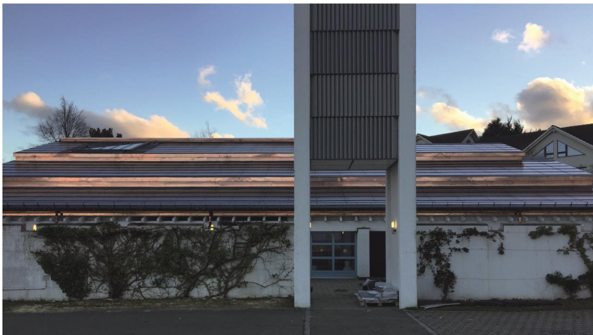
3 Durch die verbesserte Wärmedämmung und die PVT-Module beträgt der Solarstromüberschuss rund 63'000 kWh pro Jahr.
