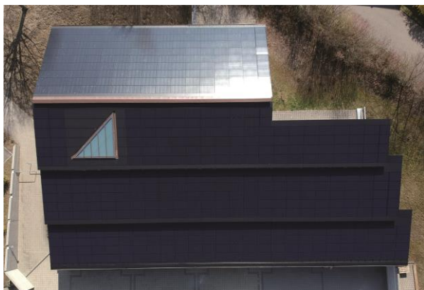
1 Vollflächig integrierte PVT-Dachanlage
