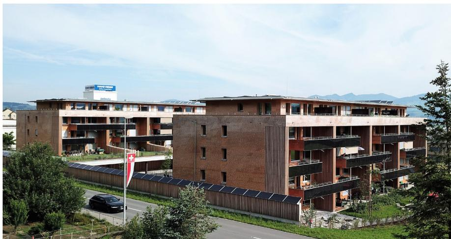
1 Die 77 kW starke PV-Anlage erstreckt sich über die beiden Dächer, die Balkonbrüstungen und die Lärmschutzwand.
